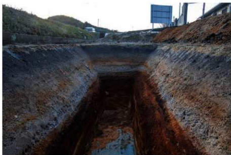
(3) 9 トレンチ西壁(東から)
