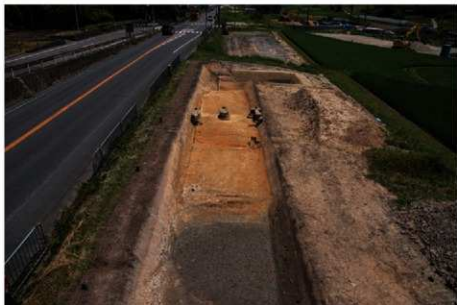
(1) 3区完掘状況(西から)
