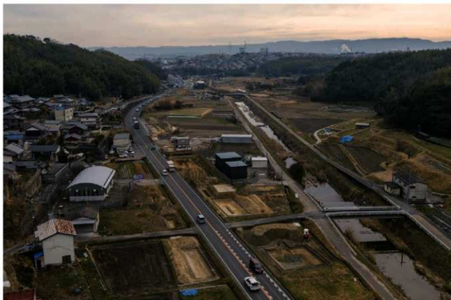
(1)調査区遠景(北東から)
