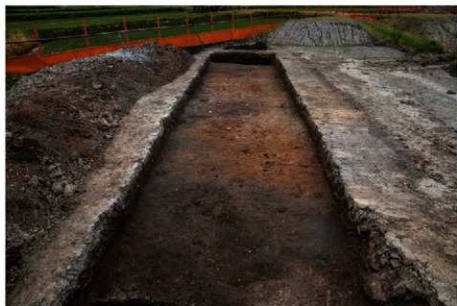
(1) 2 トレンチ全景(北東から)
