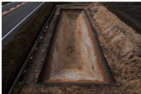
(1) 6トレンチ全景(東から)
