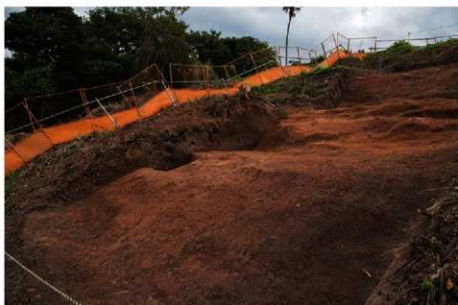
(2) 2区壁面(西から)
