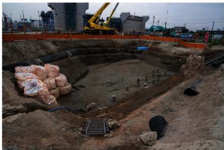
(1) E 8 区拡張前全景 (北西から)
