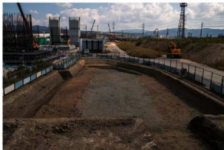
(1) G16区東半上層遺構(西から)
