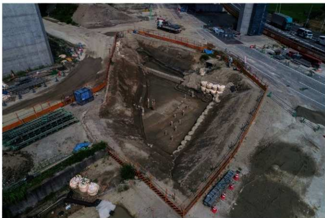
(2) E 8 区全景(南東から)
