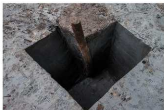
(7) G17区流路NR45SX47杭(北から)
