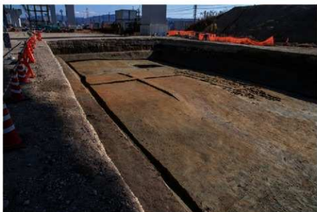
(2) F 8 a 区鳥畑128・ 溝群 S D03 検出状況 (北西から)
