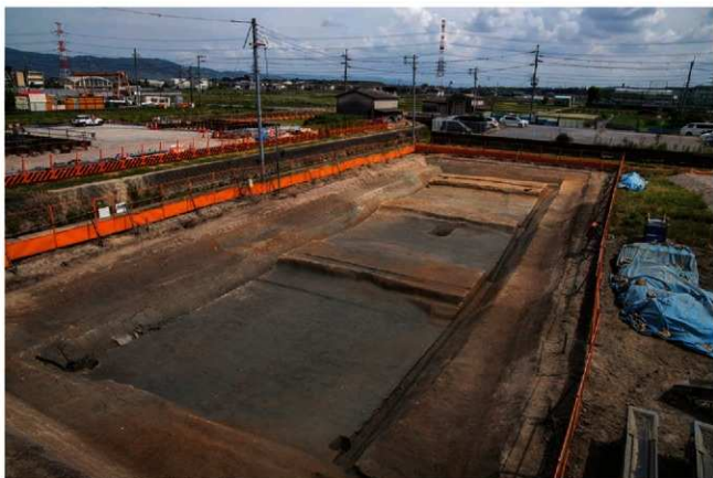
(2) F5区調査区上層全景(北西から)
