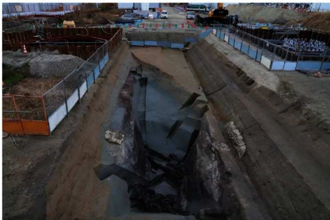
(1) F6区流路NR07全景(東から)
