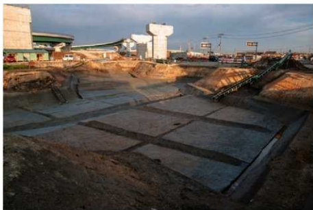
(2) E7区全景(南東から)
