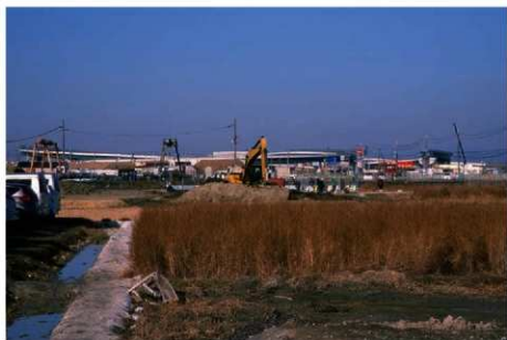
(3) G12区埋め戻し作業 (南東から)
