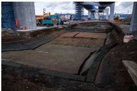
(2) F 7 区島畑126・127検出状況 (南西から)
