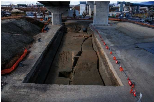
(1) F 8 a 区全景(東から)
