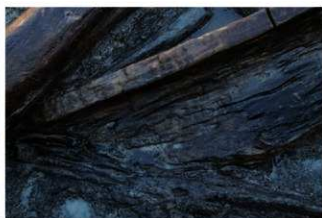
(4) F 5区流路N R07 S X13(南から)
