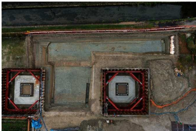
(1) G15区全景(上が西)
