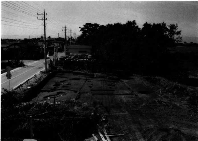
VII区全景（北側より）
