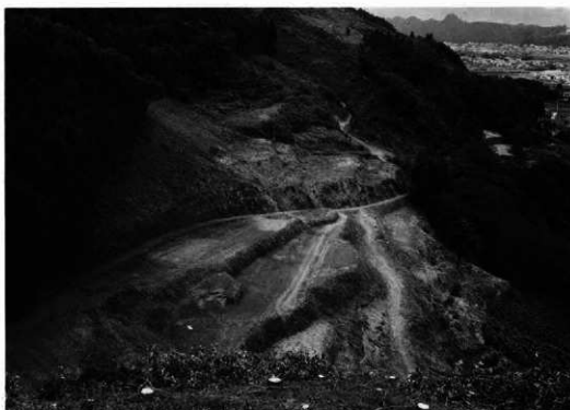
テラス④～テラス⑥ 雑草伐採後 東より
