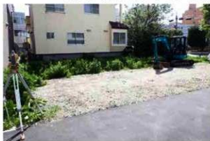
A 事業地近景 (北西から)
