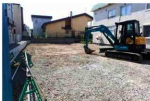
E 事業地近景 (南東から)
