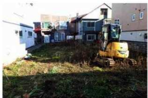
E 事業地近景 (南西から)
