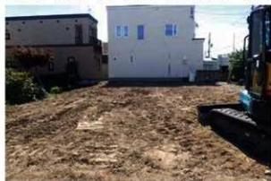
A 事業地近景 (北西から)
