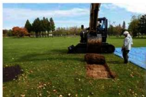
E 掘削状況
