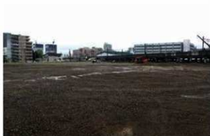
A 事業地近景 (北西から)
