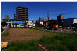
E 事業地近景 (南東から)
