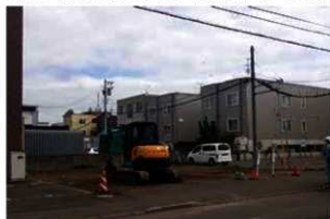
A 事業地近景 (南西から)
