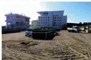
A 事業地近景 (北から)
