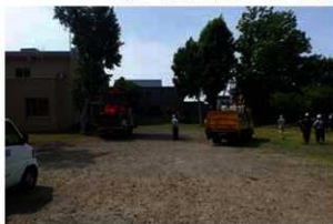
A 事業地近景 (北から)
