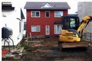
A 事業地近景 (南西から)
