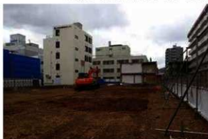
A 事業地近景 (北から)
