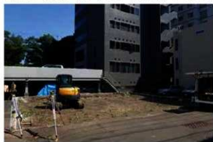
A 事業地近景 (南西から)
