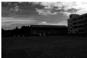
A 事業地近景(西から)
