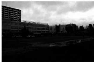
A 事業地近景(南西から)
