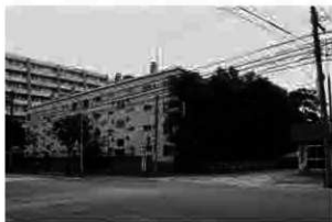
E 事業地近景(北西から)
