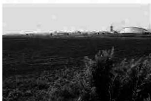
E 事業地近景(北から)
