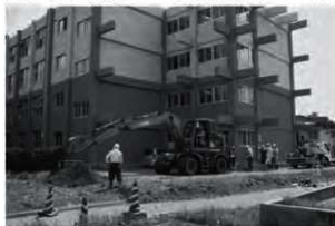
A 事業地近景(西から)
