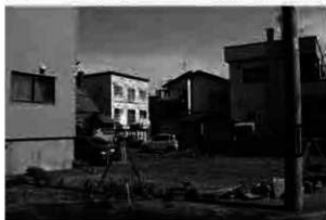
A 事業地近景(南から)
