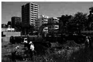
E 事業地近景(南西から)
