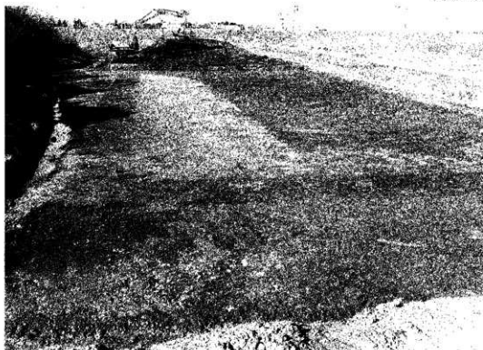
E区表土掘削状况
