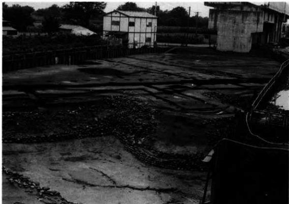
1 西辺第2張出部（北西より）
