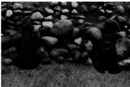
2 橋梁遺構石垣基部の支柱（北西より）
