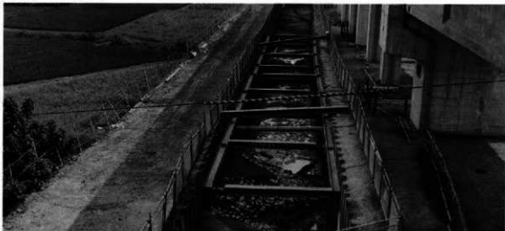
1 南辺第1張出部（手前石垣屈曲部）と南濠（1区東、北より）
