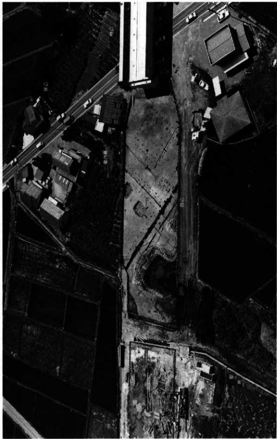
西方上空より見た第1次調査区
