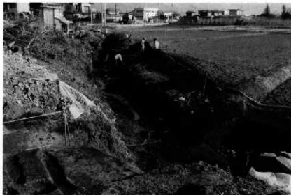
1 猿府川改修に伴う 館東辺の調査状態 (手前は第3トレン チ。南西より)
