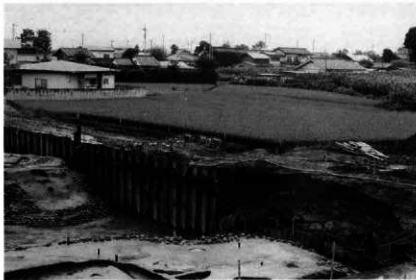
1 痕跡を留める西濠の現況（北東より）
