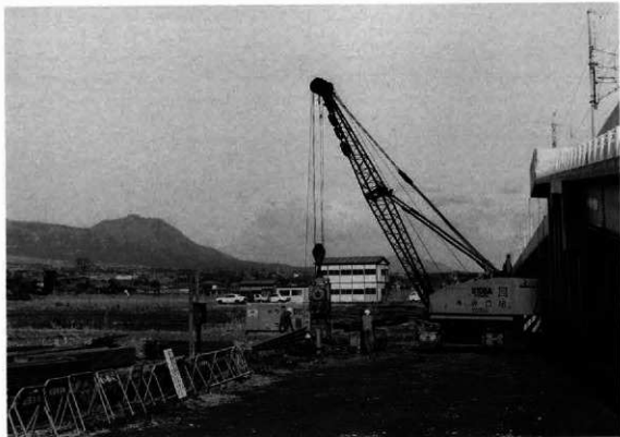
1 第2次調査前の安全対策工事（2区西）（南より）
