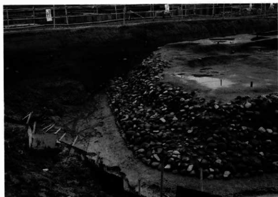
2 館西辺第1張出部先端（南より）
