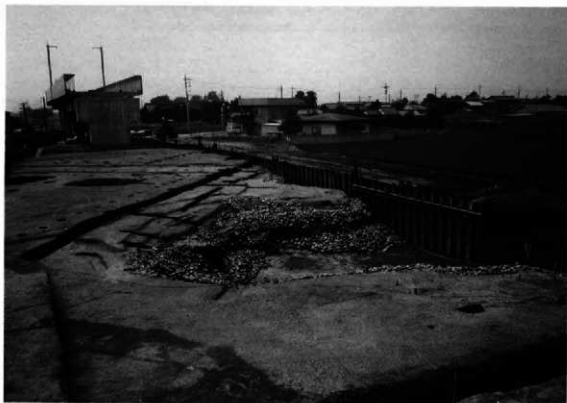
2 館西辺石垣の崩落状態（北東より）
