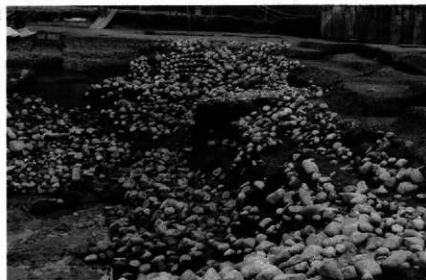
2 館西辺石垣の崩落 状態（南西より）
