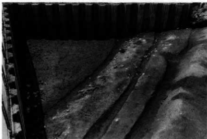
2 2区西、水田に伴う水路(東より)
