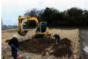
TR4 重機掘削作業
