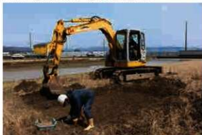
TR3 重機掘削作業
