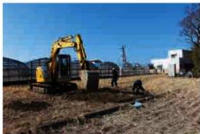
TR1 重機掘削作業
