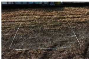
試掘坑設定状況
