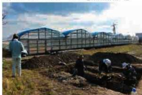
TR5 遺構掘削作業
