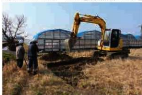
TR5 重機掘削作業
