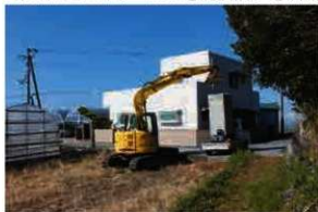
重機・仮設トイレ搬入
