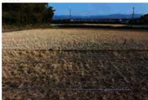
試験坑設定状況
