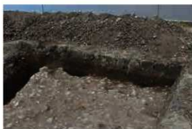
TR 4 試掘坑北壁 土層断面状況 (2017.3.29)
