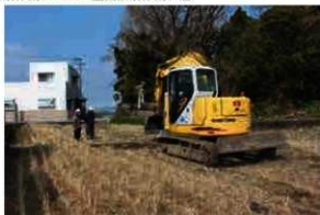
TR6 重機掘削作業
