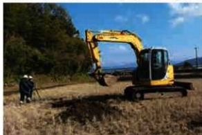
TR2 重機掘削作業
