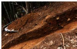
6. 2段目テラス及び西壁土層断面 (東から)
