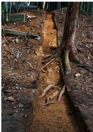
3. 墳丘部掘削状況 (南から)
