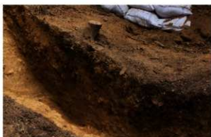
7. 東壁土層断面3 墳裾付近 (西から)
