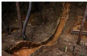
2. 掘削状況 (南東から)
