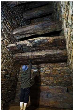
87. 奥壁と石棚（南から）
