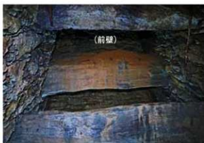
92. 石梁 (石欄上から前壁に向かって)
