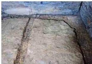
102. 玄室北東隅 排水溝完掘状況
