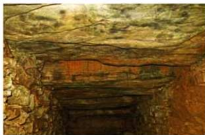
71. 羨道天井石 (南から)
