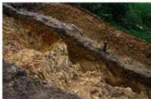
16. 6トレンチ 第1斜面岩盤層検出状況と 填丘盛土（東から）
