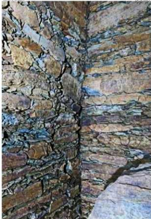
81. 玄室北西隅石棚下部 (南東から)
