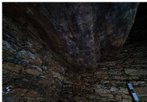
89. 石棚と東側壁（西から）
