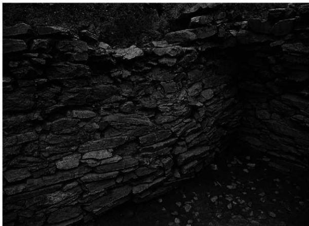
2. 玄室北側壁突起石 (2箇所) (南から)
