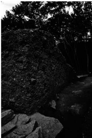
4. 東トレンチ北壁土層断面（西から）
