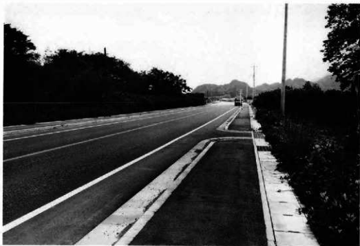
1. 調査終了後現状（北から）
