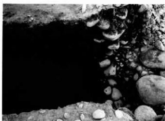
37号墳左壁裏込 (北から)
