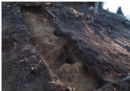
2. 2トレンチ完掘状況（北東から）
