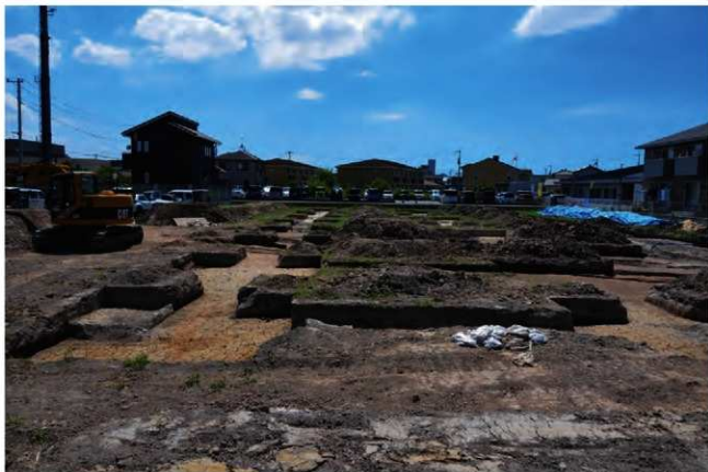
1 完掘状況（東から）
