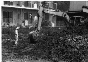
重機による表土除去
