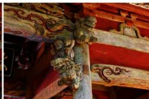
中央北東側彫刻（上から虎、力人、獅子）
