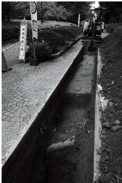
調査溝1本丸北側斜面検出状況
