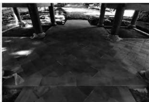
四半敷石張り
