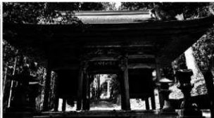
竣工 正面(東面)
