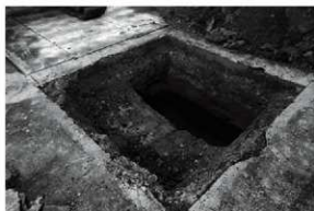
調査坑3完掘状況
