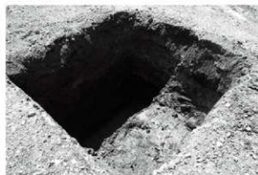
調査坑 21 完掘状況
