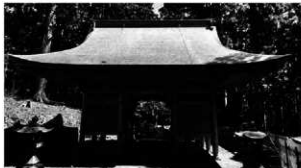
竣工 後面(西面)
