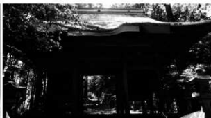
修理前 正面(東面)
