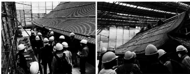
修理工事見学会
