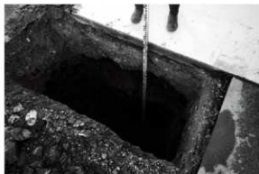
調査坑4完掘状況
