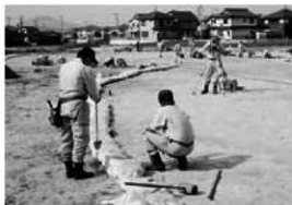
国土座標杭設置（今市遺跡）
