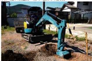
1. 重機掘削の様子 (北東から)
