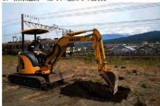
1. 重機掘削の様子 (南東から)
