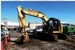
1. 重機掘削の様子 (南西から)
