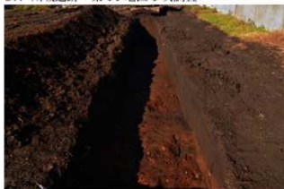
1. 1Tr完掘 (南東から)
