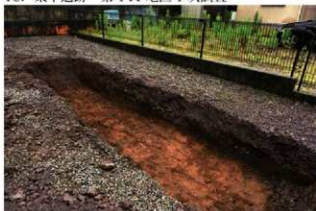
1. 1Tr完掘(南西から)
