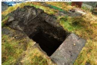
1. 1Tr完掘 (南東から)
