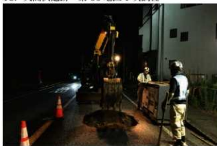
1. 2Tr重機掘削の様子(北西から)
