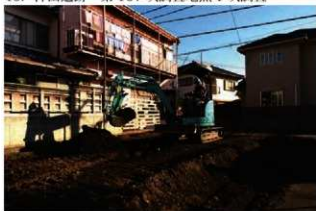
1. 重機掘削の様子 (南西から)
