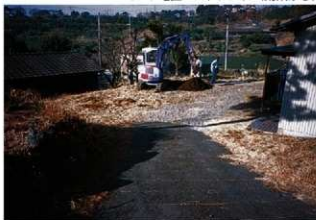
6. 5地区 重機掘削の様子 (東から)
