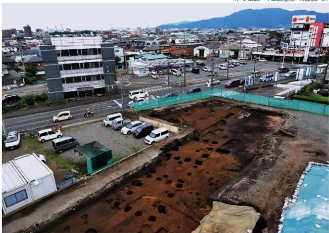
2. 3工区・4工区全景（北東から）
