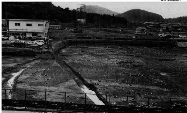
B-7・8区 (北から)
