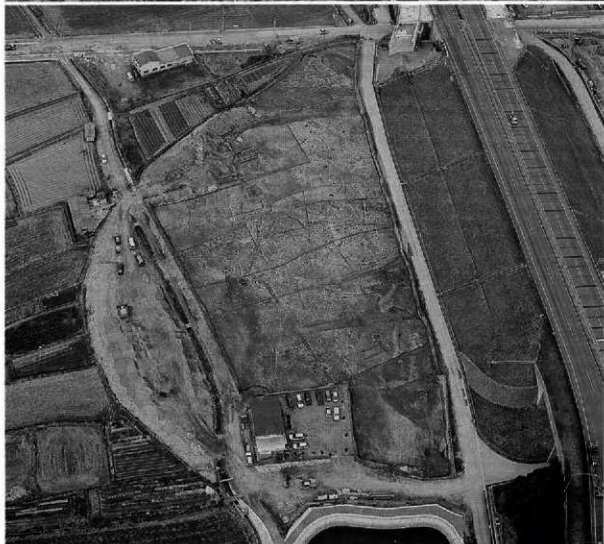
No. 1 地点全景 (東から)
