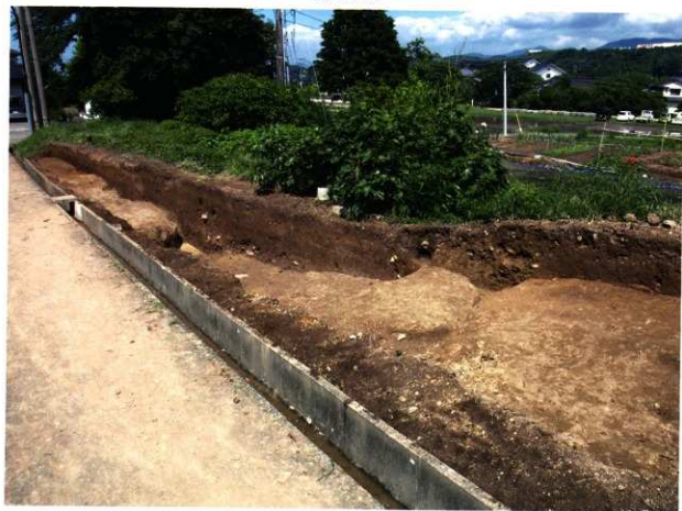
完掘状況（南西から）
