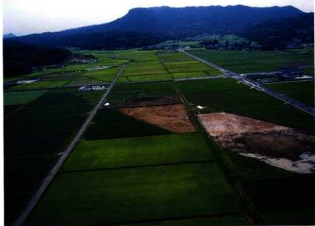
3区空中写真(南から)
