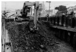
重機による表土除去作業
