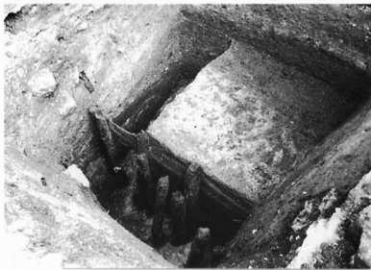
3. 西外堀の土留め
