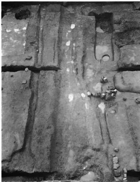
1. A地区屋敷境溝と築地跡
