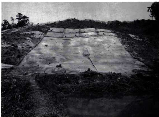
2. 調査後の全景(西より)
