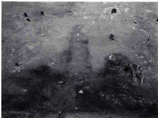
1. 窯体上面確認状況
