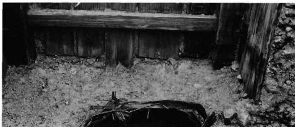
4. SE12 隅柱 東から
