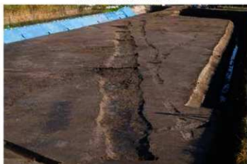
SD169・170・171・172 完掘状況 (南西から)
