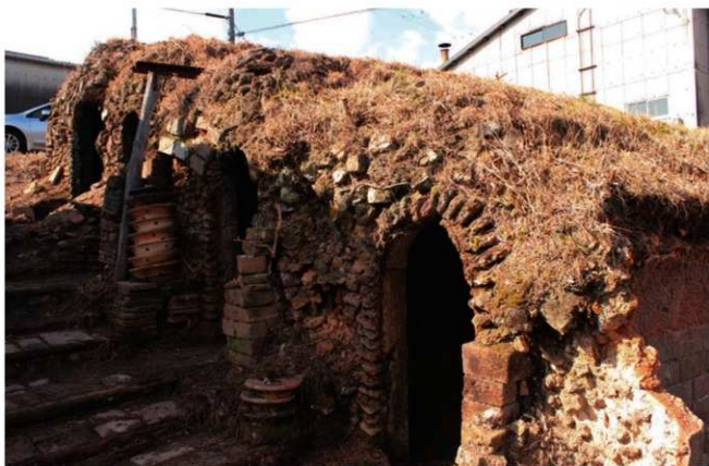
写真 45 : 22-10 次 残存する焼成室入口
