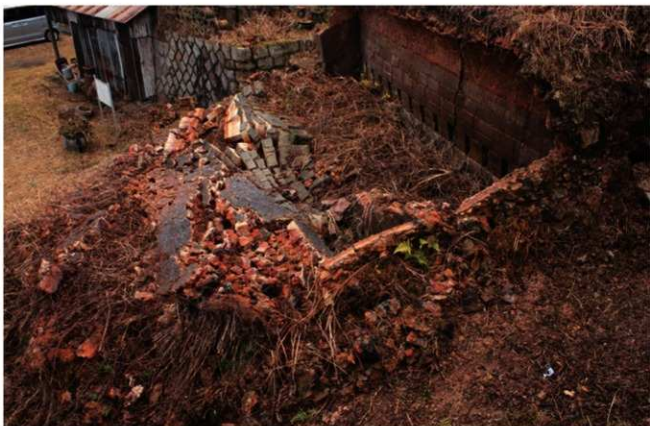
写真 40 : 22-10 次 崩落状況 (西から)
