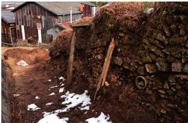
写真 46 : 22-10 次 残存する覆屋の支柱
