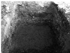
写真 22 トレンチ全景
