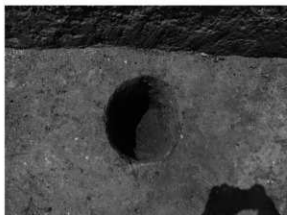
写真8 1トレンチピット完掘
