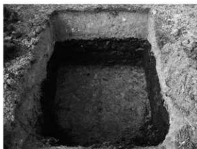
写真 24 トレンチ全景
