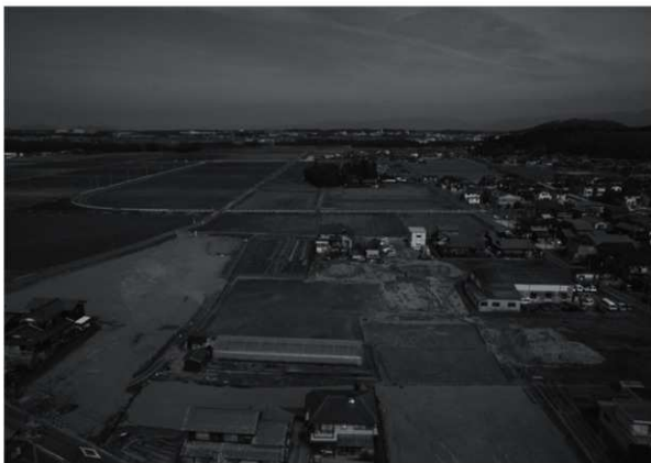
T4-5遠景（南西より）
