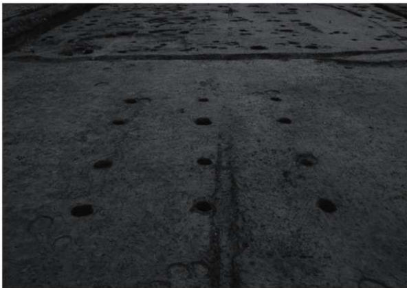
T5 建物7 (南東より)
