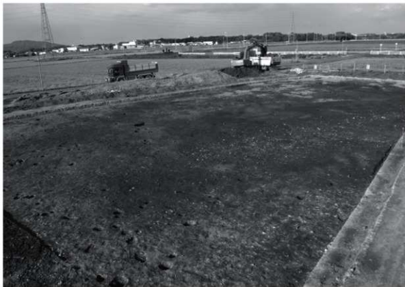
T1全景 (南より)
