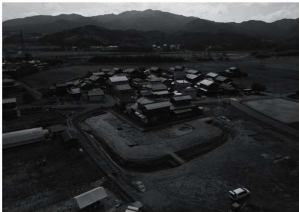
T3 全景 (東より)
