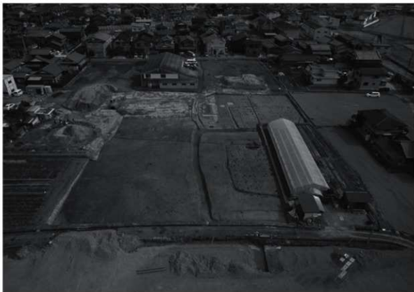
T4-5 全景 (北西より)
