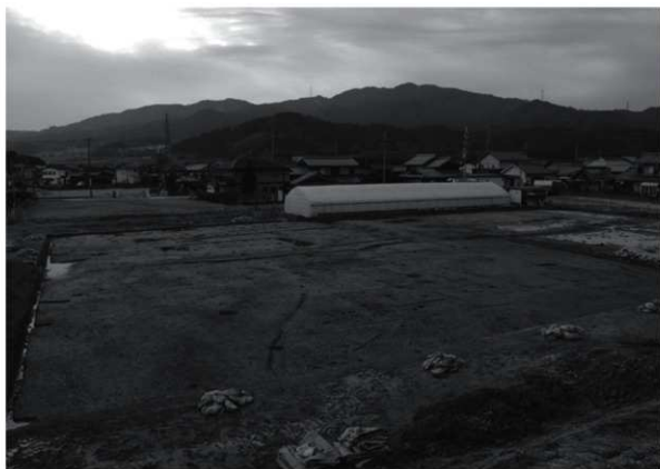
T5 北半部全景（東より）
