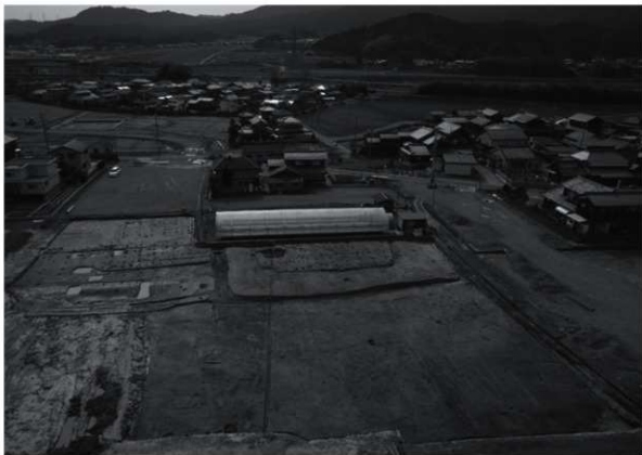
T4・5全景（北東より）
