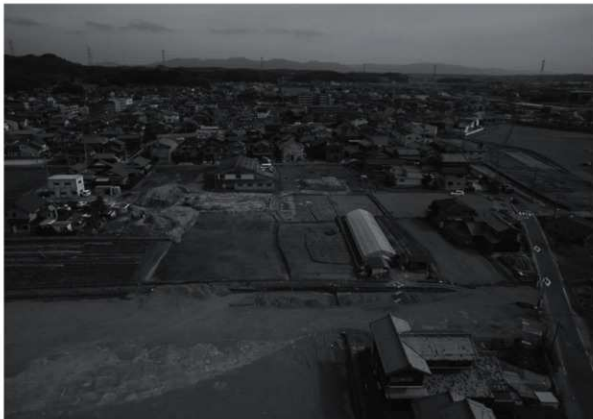
T4-5 遠景 (北西より)
