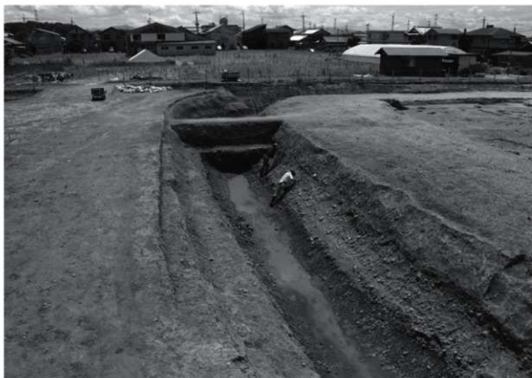
T3 堀S1完掘状況
