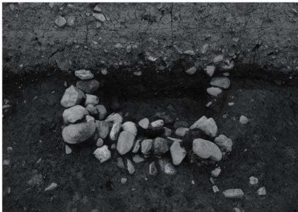
T3 石組土坑S67 (南東より)
