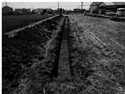
21 R 1 - No.26 杉ノ下遺跡 (北東から)
