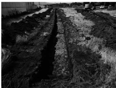
29 R 1-No36 烏山下遺跡（南東から）
