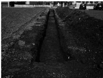
10 R 1-No342 土遺跡 (南から)
