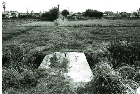
乙宮橋修復後
