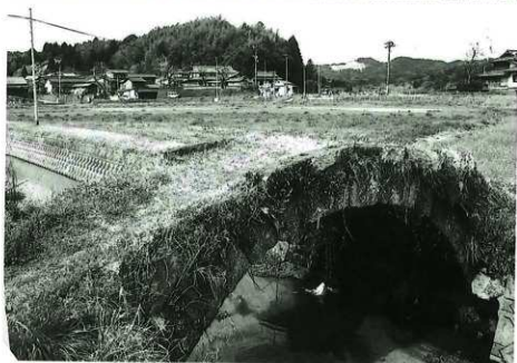
石貫車橋 (南から)
