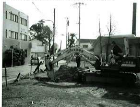
ふれあい広場建設予定地調査状況
