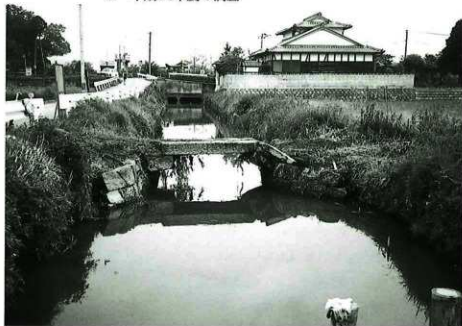
乙宮橋近景 (西から)
