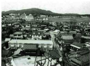
保田木城跡・光蓮寺跡周辺(工事後南から)
