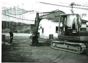
築地市場遺跡調査状況(南から)
