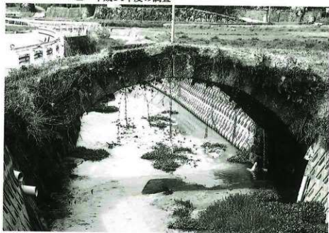
石貫車橋近景 (南西から)
