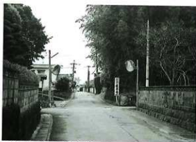
田嶋遺跡A地点西側道路部分(北から)
