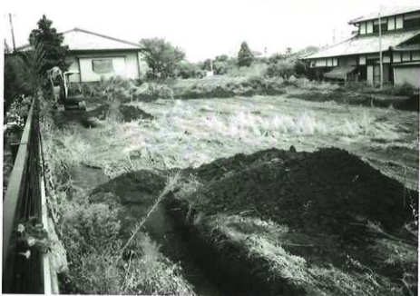
糖峯遺跡 確認調査状況(西から)
