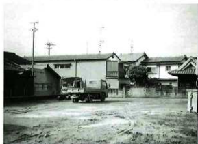
保田木城跡・光蓮寺跡調査前状況(東から)
