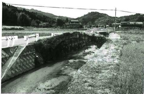
石貫車橋 (南西から)
