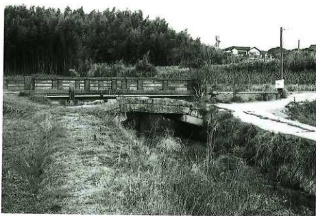
石造十六橋近景 (南西から)
