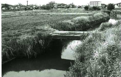
乙宮橋修復後 (東から)
