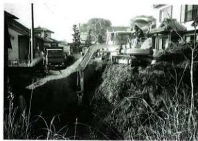
菊尾遺跡調査地南側工事状況(東から)
