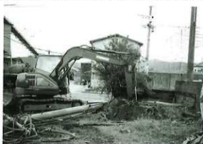
築地市場遺跡調査状況(南から)
