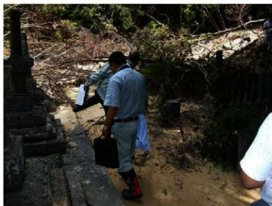
災害時の被害確認
