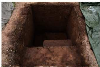
東空閑城跡 TP5 完掘状況（南西から）
