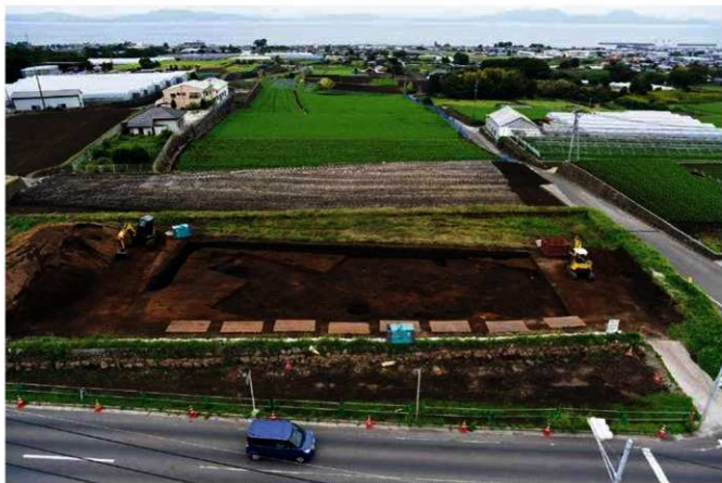
調査区近景（南西方向から有明海を望む）
