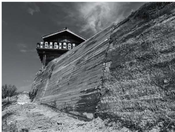
写真53 土壘修復状況（東から）
