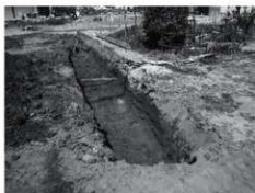
写真6 擁壁掘削状況
