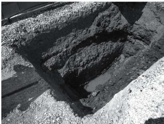
写真28 調査地掘削状況
