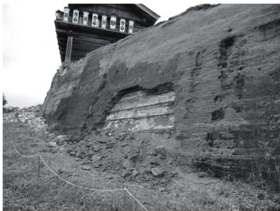
写真52 土壘崩落状況（東から）
