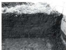
写真40 基礎掘削断面
