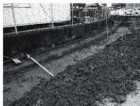
写真13 擁壁掘削状況
