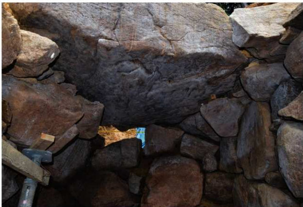
玄室天井石 (南から)
