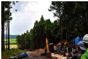
写真2 空中写真撮影の作業風景
