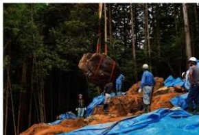
写真1 天井石撤去の作業風景
