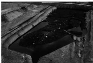
豪雨翌日の冠水状況 W → E
