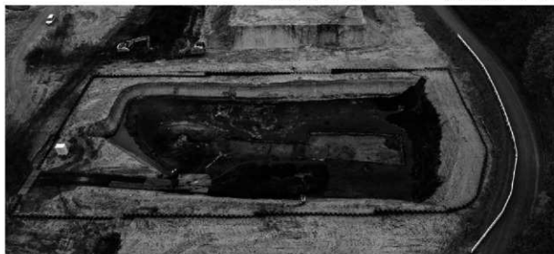
調査完了状況 S→N
