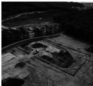
重機による表土除去作業 NW→SE
