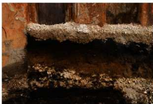
基本土層 (ハ3杭付近) NW→SE
