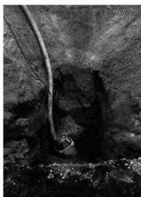
カメラ場設置状況 E→N
