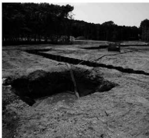
沈殿槽設置状況 SE→NW
