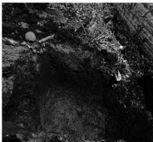
土層断面 (14S 杭) W→E
