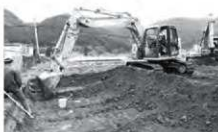
写真2 重機作業風景
