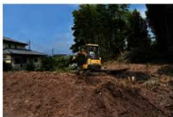
調査箇所全景
