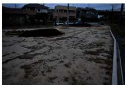
調査箇所全景
