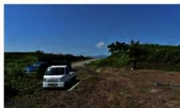
調査箇所全景
