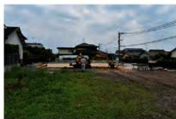
調査箇所全景
