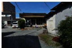
調査箇所全景
