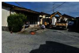
調査箇所全景
