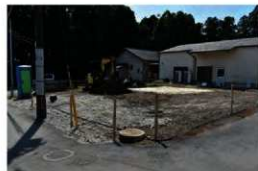
調査箇所全景
