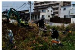
調査箇所全景
