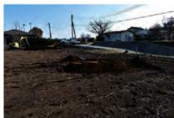
調査箇所全景
