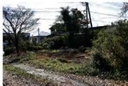
調査箇所全景
