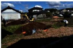
調査箇所全景
