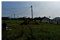
調査箇所全景
