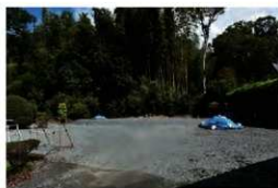
調査箇所全景
