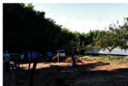
調査箇所全景
