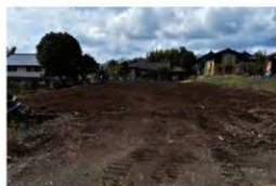
調査箇所全景
