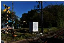
調査箇所全景
