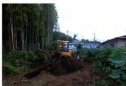
調査箇所全景
