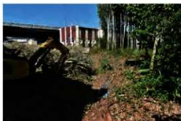
調査箇所全景
