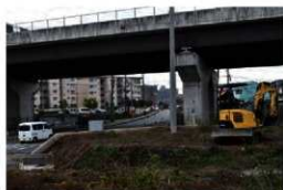
調査箇所全景
