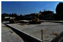
調査箇所全景
