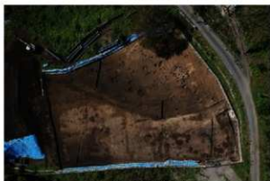
14区全景 (上が南西)
