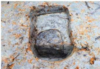
SB8305-P8270 断面(西から)
