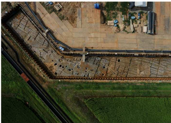
第3面(49～53W、49～52X区) 完掘(上空南東から)
