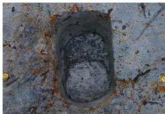
SB8305-P8270 完照(西から)
