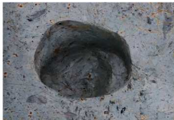
SB8305-P8271 完照(西から)
