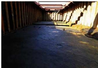
第6面 完掘(南東から)
