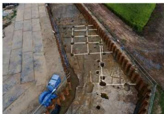
SB8251・8252 完掘 (西から)
