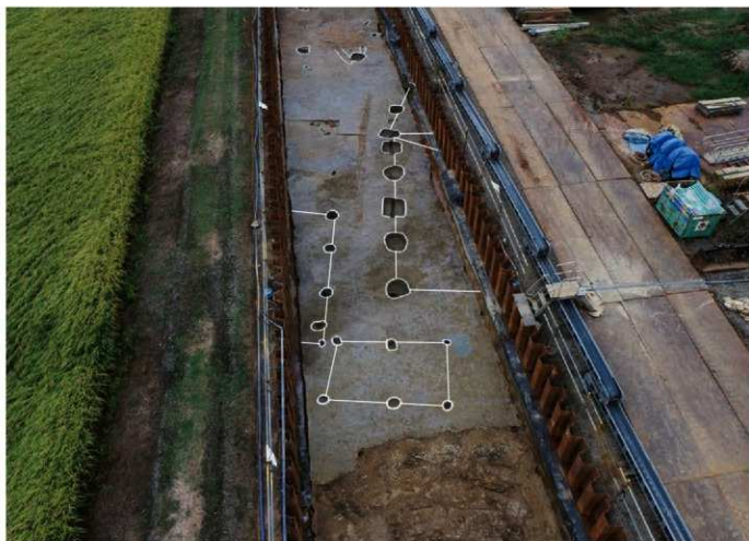
S88259・8305・8306・8307 完掘(東から)
