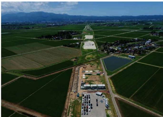
市道区 遠景(北東から)
