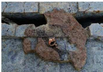
S18502-SF8544 検出状況(東から)
