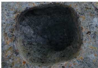
SB8306-P8273 完掘(南から)
