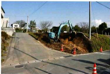
11 A区周辺掘削状況（南から）
